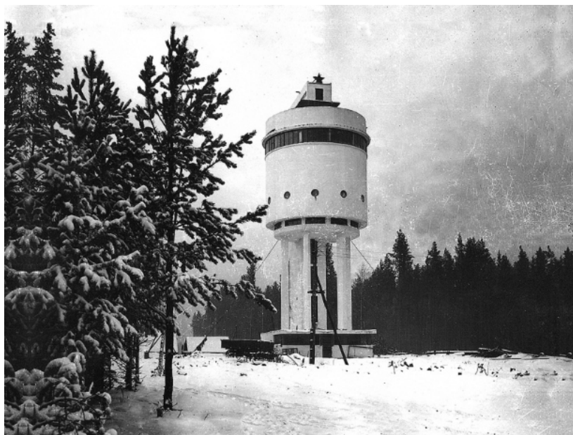
Рис. 6. Водонапорная башня УЗТМ, 1931
