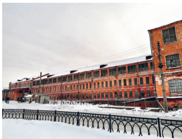
Рис. 2. Главный корпус Арамилской суконной фабрики. Арамиль, Свердловская обл. Фото из свободного доступа в Интернет.
