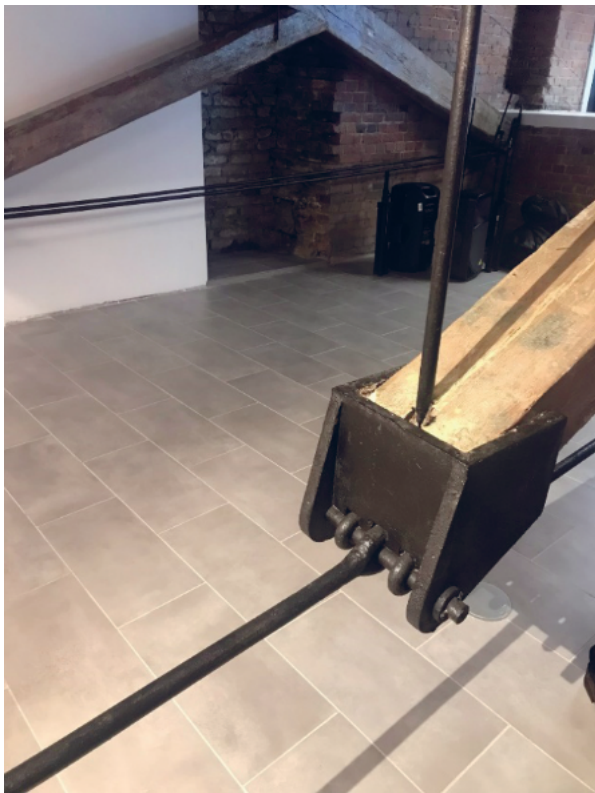
Рис. 1. Историческая часть здания Культурно-просветительского центра «Эрмитаж-Урал» (фото В.Н. Поповой).
