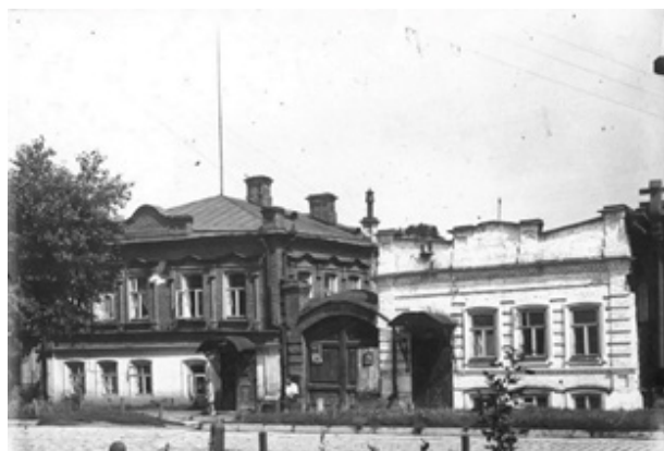
Рис. 2. Фрагмент ул. Февральской революции (1929-1940) Россия, Свердловская область, Екатеринбург. Не сохранились. Источник: https://gokatalog.ru/portal/#/collections?id=24113833
