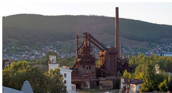
Рис 2. Доменная печь Белорецкого металлургического завода. Фото К. Д. Бугрова
